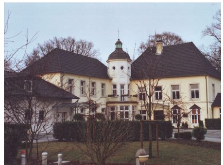
Bild 2: Dudens Geburtshaus. Damals Gut Bossigt in Lackhausen bei Wesel, heute Hotel Haus Duden.
